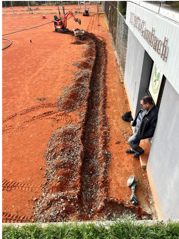
Abbildung 4 Auf Platz 1 wird die dickere Wasserleitung verlegt
