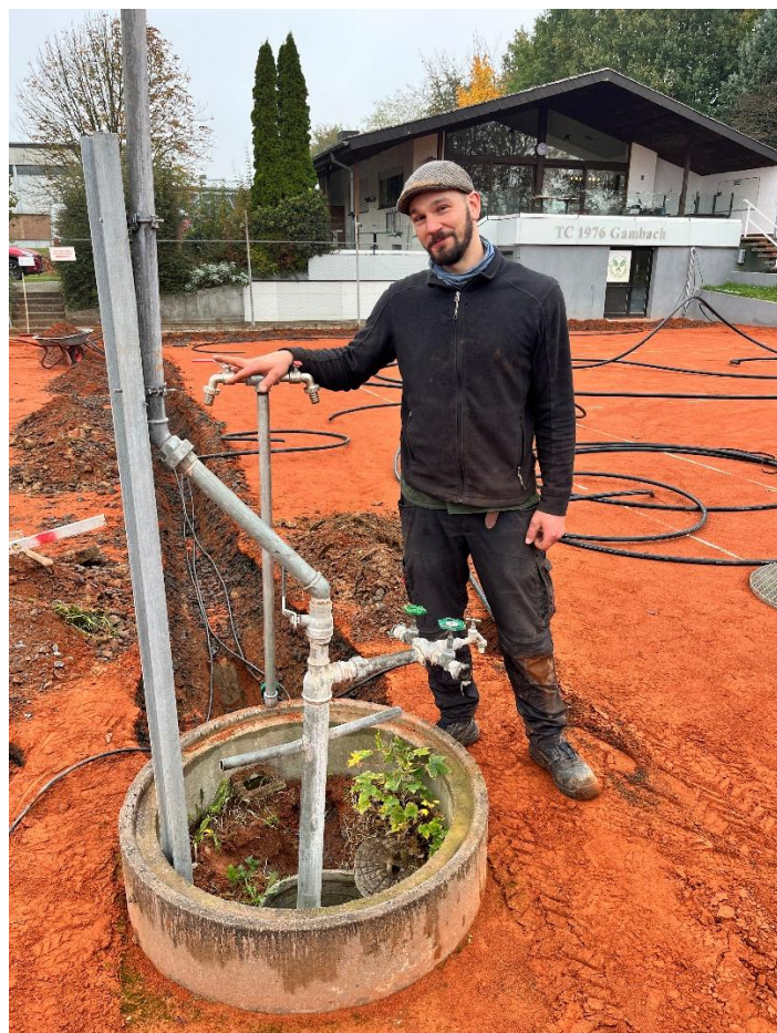
4 Schlauchanschlüsse und Wasserhähne werden erneuert
