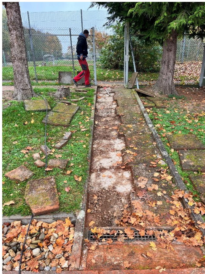
2 Ein Stromkabel wird zu den Plätzen 5+6 gezogen
